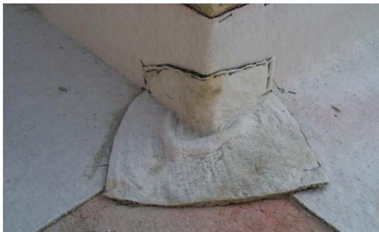
Imaginea 4 – Întinderea Bentotelo pe un colț deschis.
