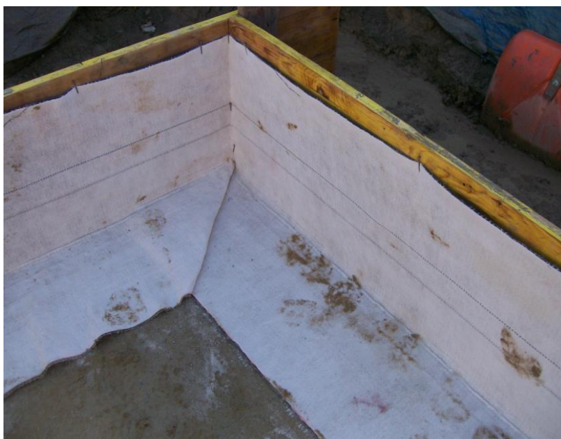
Imaginea 3 – Întinderea Bentotelo pe un colț închis.
