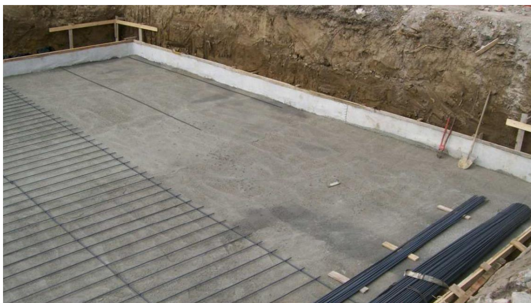
Imaginea 7 – Strat de protecție turnat peste Bentotelo.
