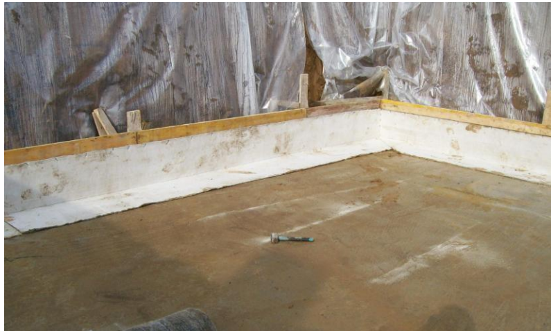
Imaginea 2 – Întinderea Bentotelo pe cofraje
